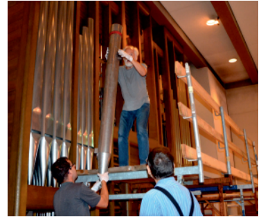
Demontieren der Orgelpfeifen
